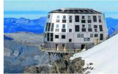
Pour répondre aux conditions climatiques extrêmes liées à cette altitude, un modèle de fenêtre très performant a été réalisé. Elle est constituée d'un triple vitrage et d'un survitrage spécifique. Pour l'isolation entre chaque vitre, l'argon a été choisi comme gaz plutôt que l'air, augmentant ainsi la résistance thermique de la fenêtre.
